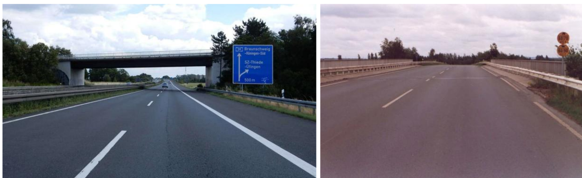
Abbildung 5: Exemplarische Bilder des Bauwerkes Z19e
