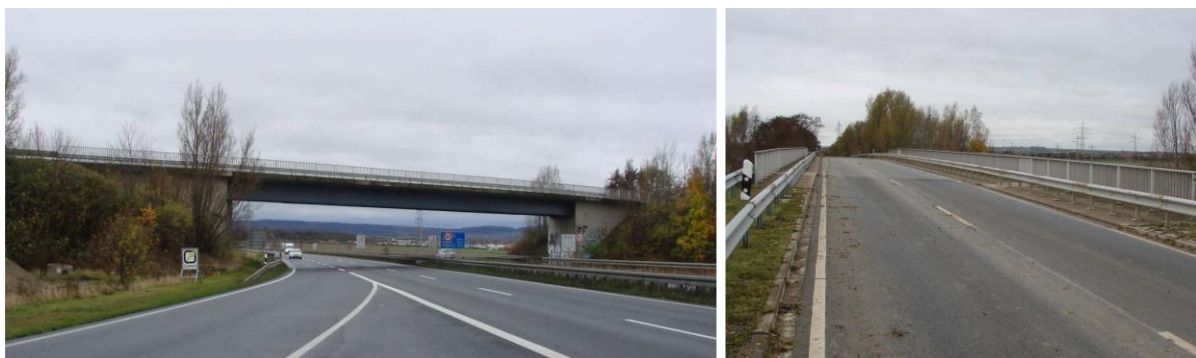
Abbildung 3: Exemplarische Bilder des Bauwerkes Z16
